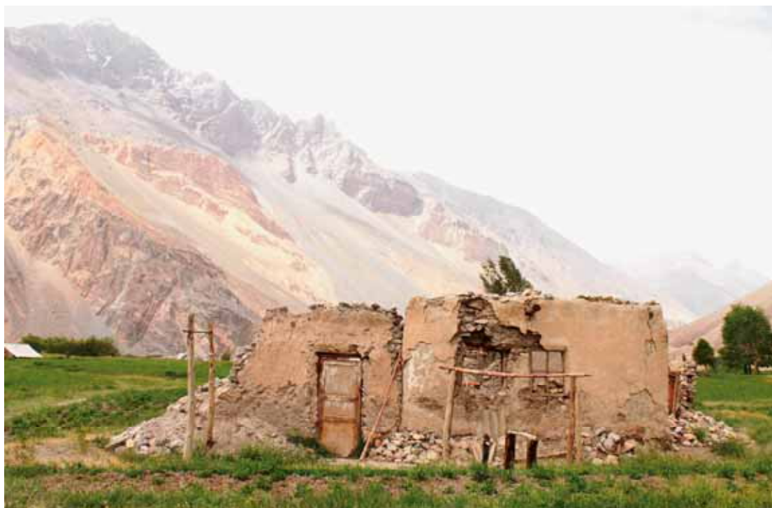
Фотография 15.1: Разрушенные землетрясением в декабре 2015 г. дома в селе Кудара, Бартангская долина, ГБАО
