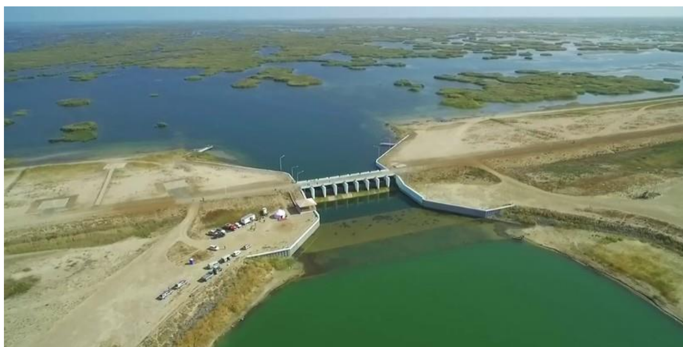
Рис. 3. Плотины Кок-Арал, вид сверху. Фото с сайта http://travelask.ru/blog/posts/12184-dve-strany-odna-problema-buduschee-arala-v-rukah-kazahstana?utm_referrer=https://zen.yandex.com
