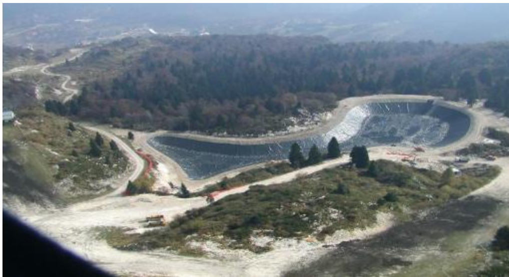
5.9-сурет. Полигон еңістіктерін сүзілуге қарсы экранмен жабу үлгісі [27]
