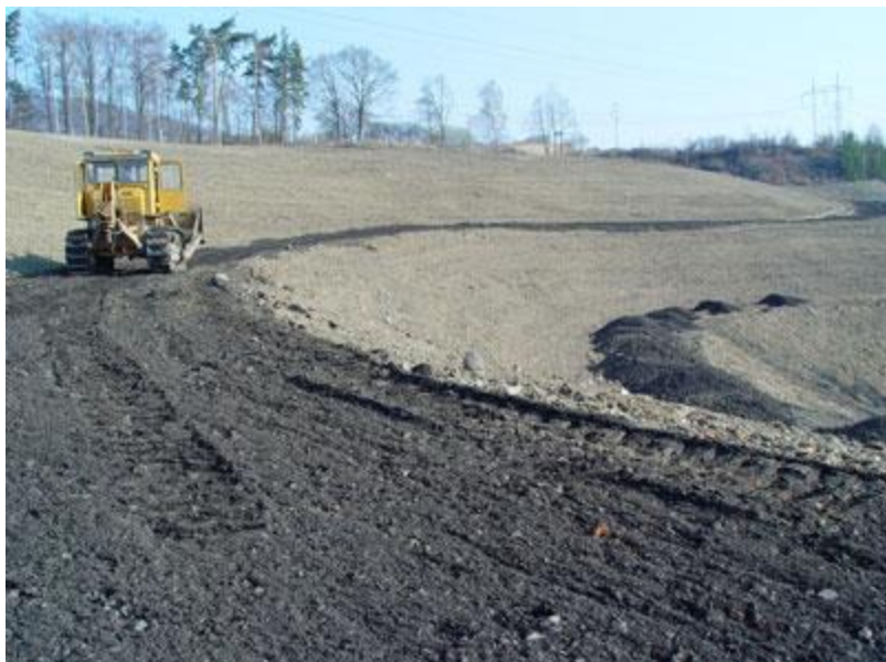
5.23-сурет. Полигон аумағының дайындалған еңістігіне қарашірік төгіп, біржола көму
