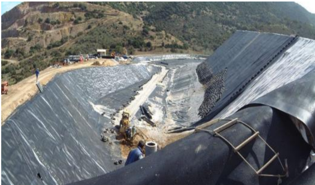
5.8-сурет. Қоршау құрылғыларының сыртқы еңістіктерін нығайту үлгісі [30]
