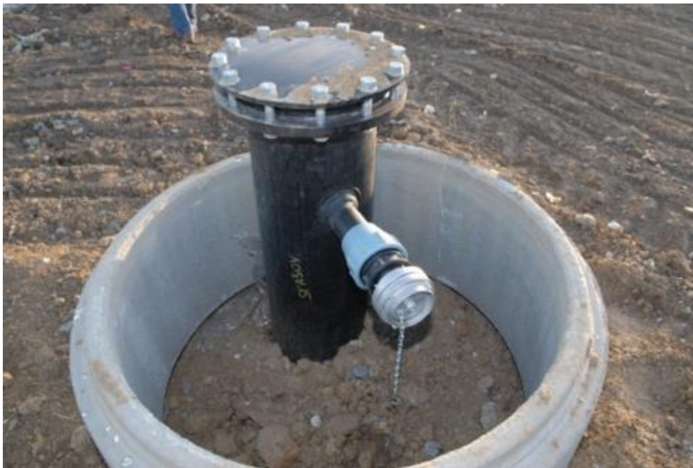
5.11-сурет. Инертті қалдықтар полигонындағы газсыздандыру ұңғымасы (Либчице) Экономика
