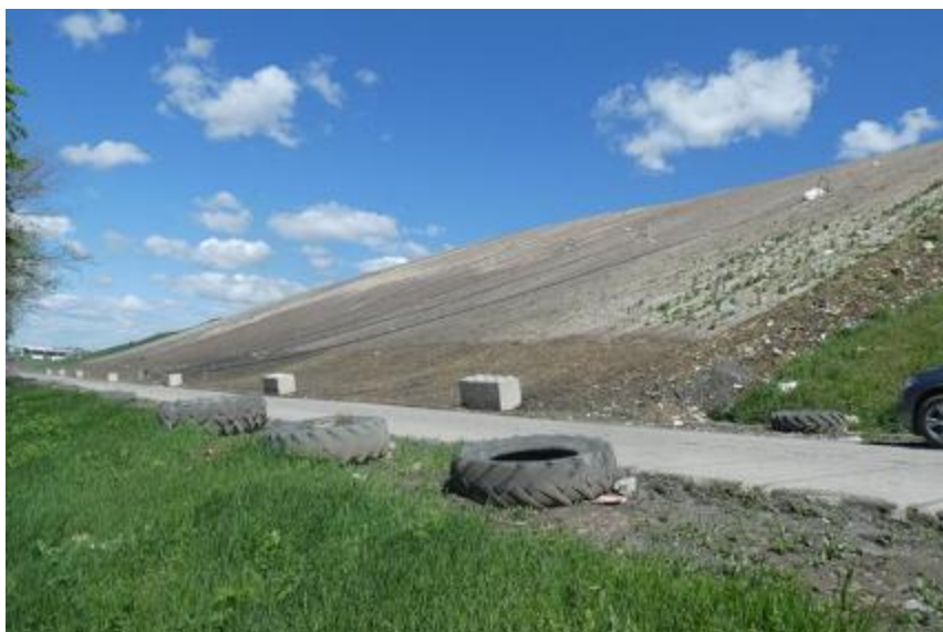
5.24-сурет. Полигонның эрозияға қарсы жабыны бар және көлденең ашық газсыздандыру дренажы бар еңістігі
