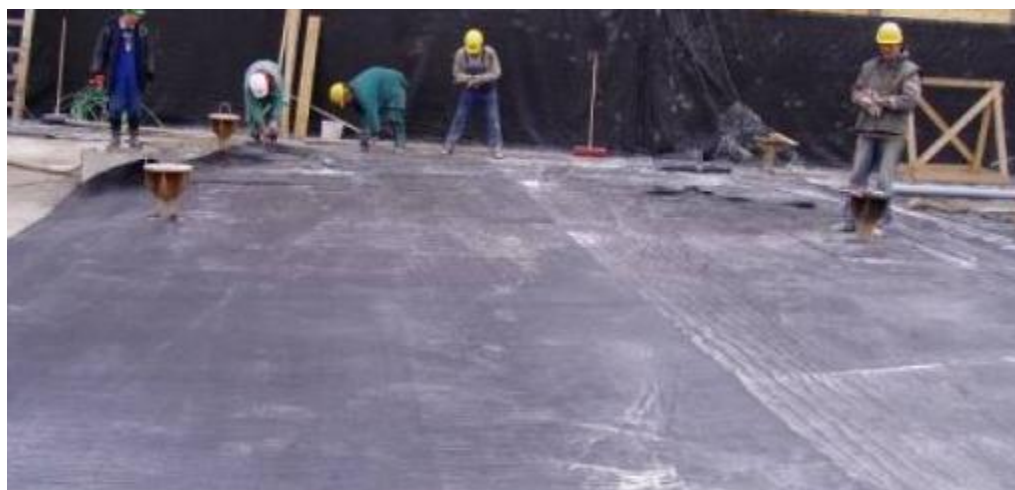
Рисунок 5.2. Пример размещения бентонитовых матов на изолируемой поверхности
