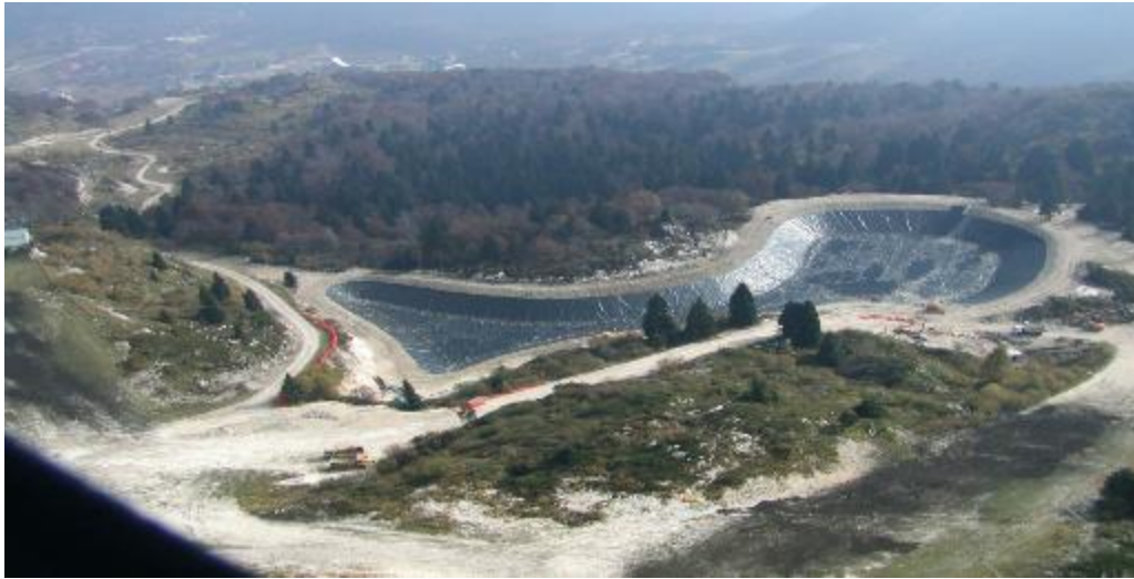
Рисунок 5.9. Примеры покрытия откосов полигона противодиффузионным экраном [27].
