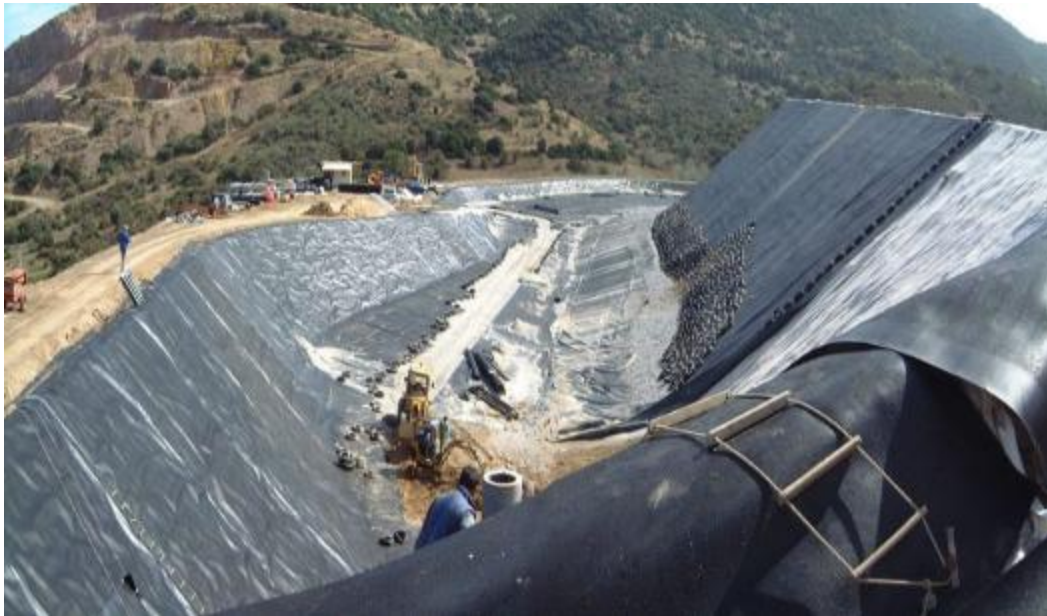
Рисунок 5.8. Пример укрепления внешних откосов ограждающих устройств [30].
