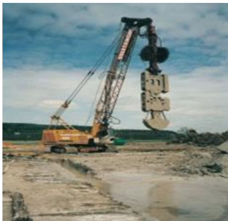
Рисунок 5.7. Геоизоляция полигона с герметизацией подземной стены (Кема Скальна) [29].
