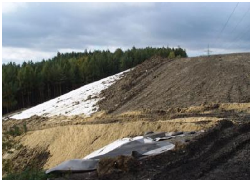
Рисунок 5.22. Укладка рекультивационных слоев.
