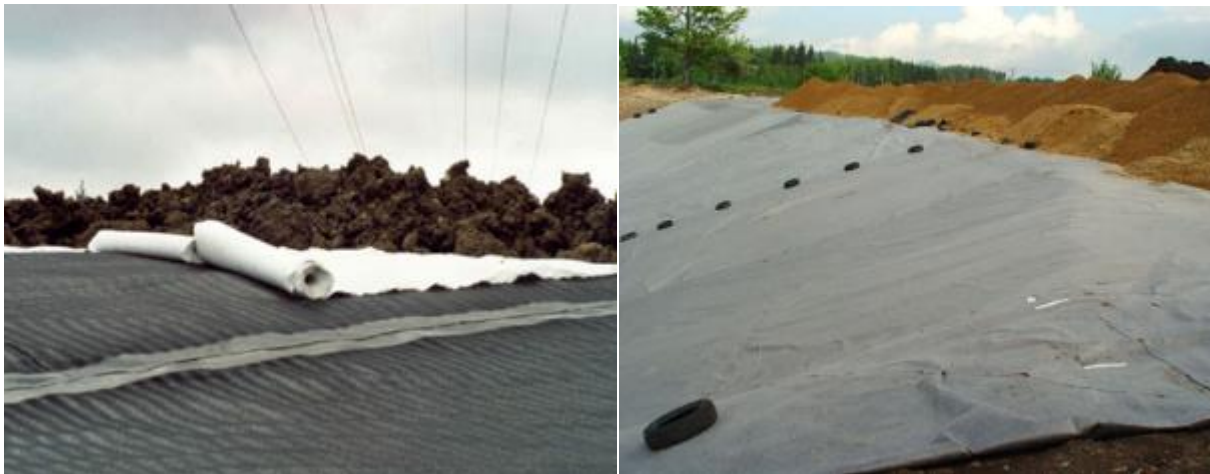
Рисунок 5.21. Рекультивация полигонов, укладка изоляционных слоев [36].
