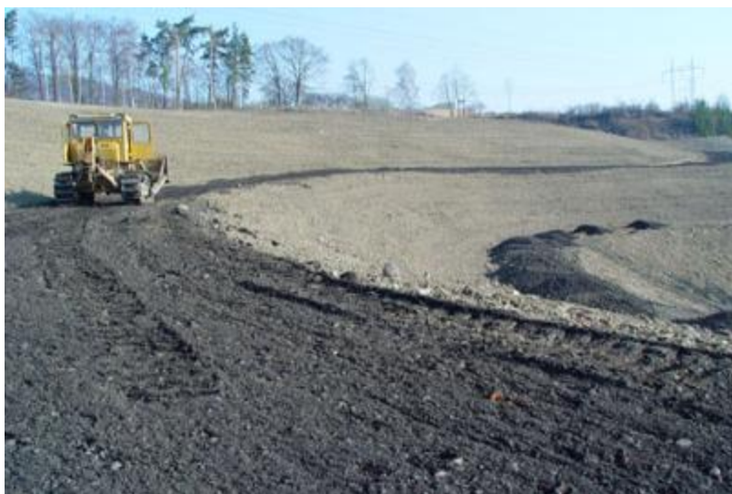
Рисунок 5.23. Окончательная засыпка гумусом подготовленного откоса тела полигона.
