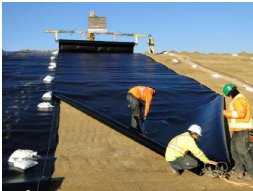
Рисунок 5.1. Процесс укладки комбинированного экрана [27].
