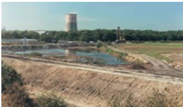
Рисунок 5.6. Рекультивация токсичного полигона с использованием изоляционной стены ECOSOL (Сполана Нератовице) [29].
