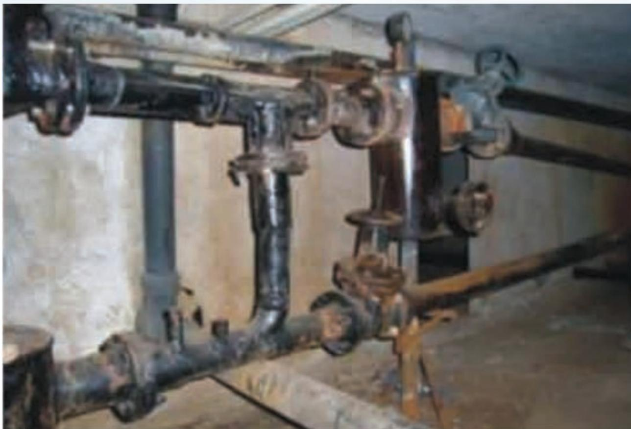
**Элеватор** — водоструйный элеватор предназначен для понижения температуры сетевого теплоносителя, поступающего из сетей теплоцентрали, за счёт частичного смешивания с водой.
