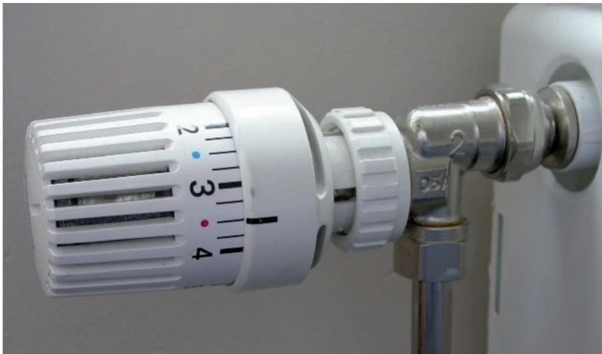
Установка термостатов на отопительные приборы позволяет снизить теплотребление еще на 5-10%, при этом стоимость их колеблется от 20-30\$ США, увеличивает стоимость строительства квадратного метра жилья на 0,001%, или примерно на 1,6\$ США.
