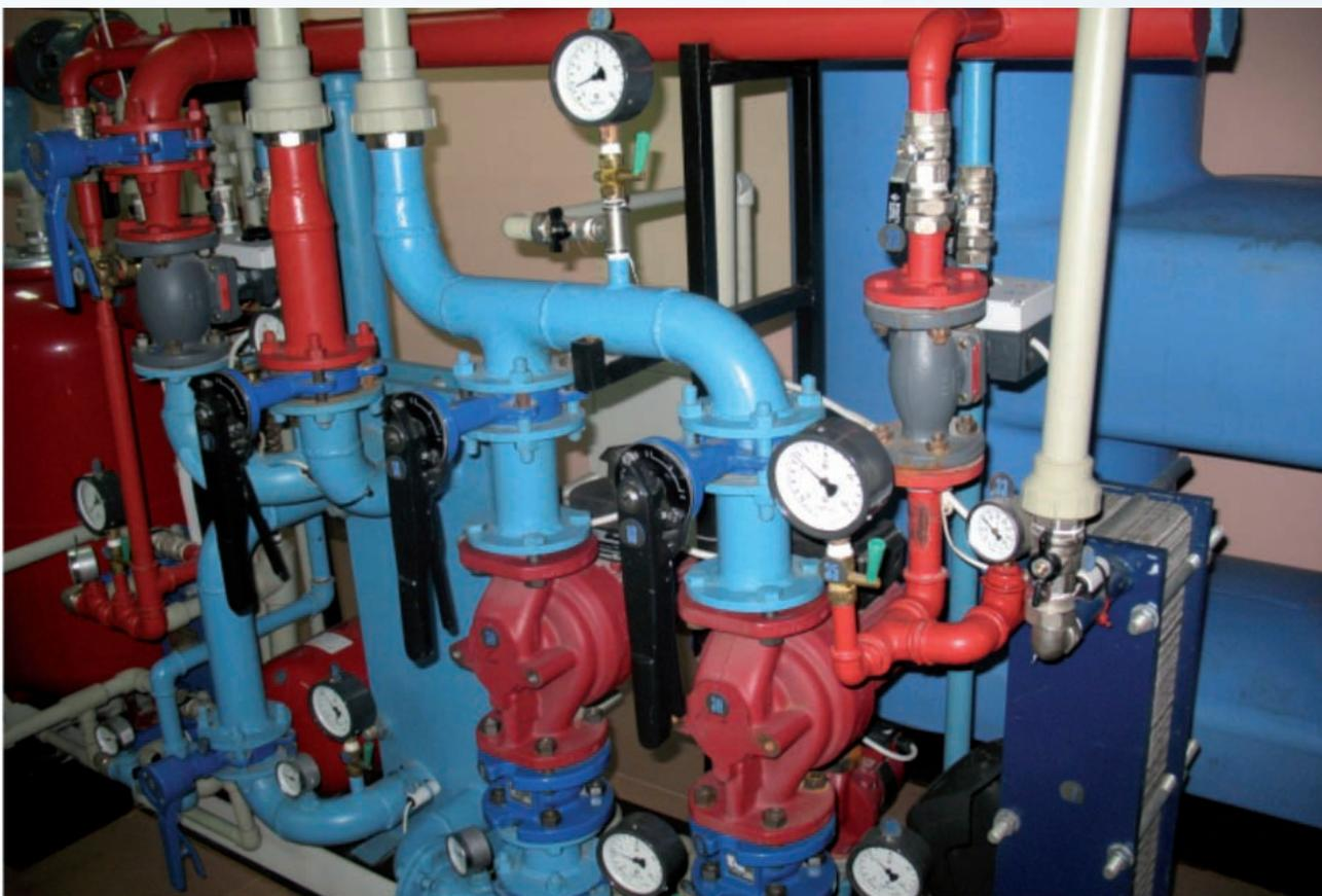
**Автоматизированные тепловые пункты** предназначены для контроля и автоматического управления значениями параметров теплоносителя, подаваемого в системы отопления, горячего водоснабжения (ГВС), вентиляции и кондиционирования с целью оптимизации теплорепления.
