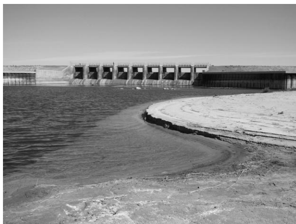
Рисунок 7. Кок-Аральская дамба с плотиной, вид с нижнего бьефа (сентябрь 2007 г.) (фото: И. Плотников).
