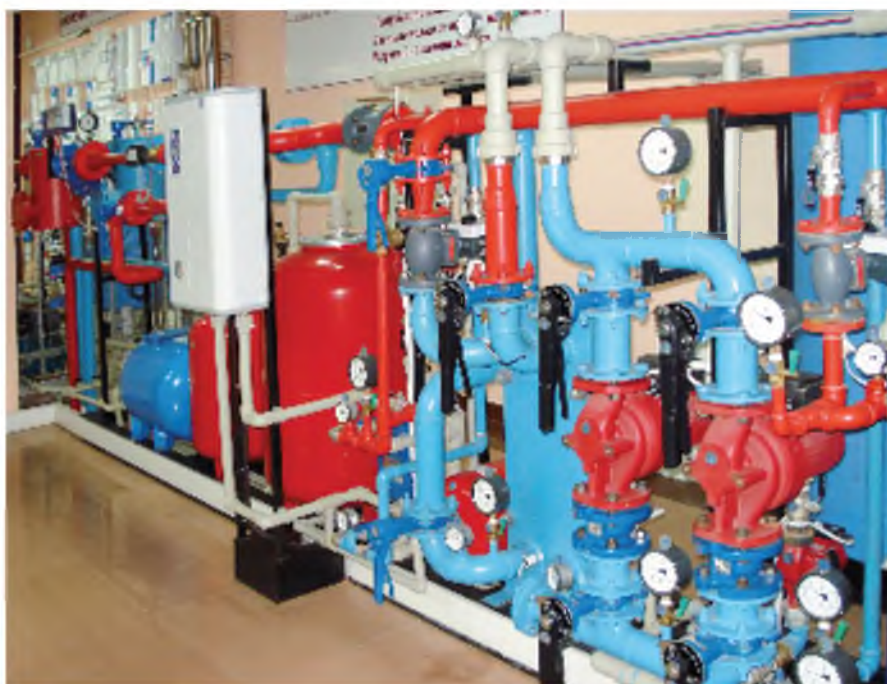
Рисунок 2 – АТП, смонтированный в здании торгового дома «Эргономика»
