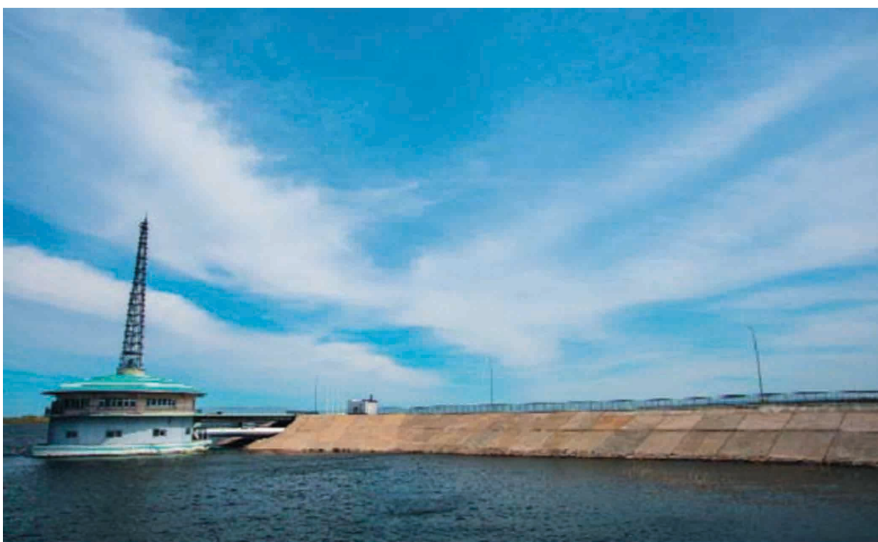
Рисунок 103. Водозабор питьевого водоснабжения г. Астаны на Астанинском водохранилище
