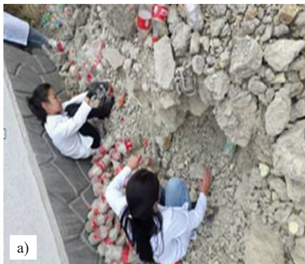
9 сурет – "СКЗ-У" өндірістік қалдықтарын ұсақтап, ПЭТ-бөтелкелерін толтыру
