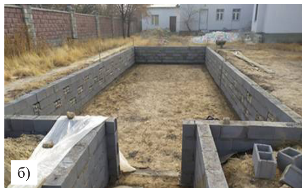
10 сурет – ҚТҚ және құрамында күкіртті бар өндірістік қалдықтарды пайдалана отырып, жылыжайдың қабырғаларын төсеу (а, б)
