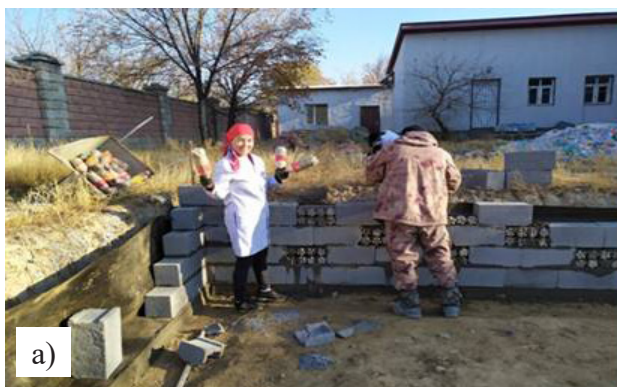
10 сурет – ҚТҚ және құрамында күкіртті бар өндірістік қалдықтарды пайдалана отырып, жылыжайдың қабырғаларын төсеу (а, б)
