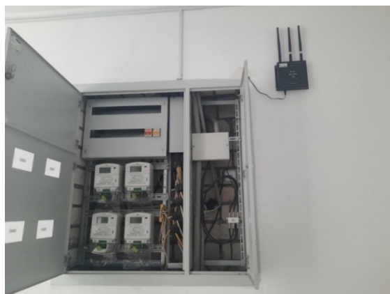
Сурет 3 –LoRaWAN жүйесімен жабдықталған көп пәтерлі тұрғын үйде оратылған көп тарифті бір фазалы санауыш
