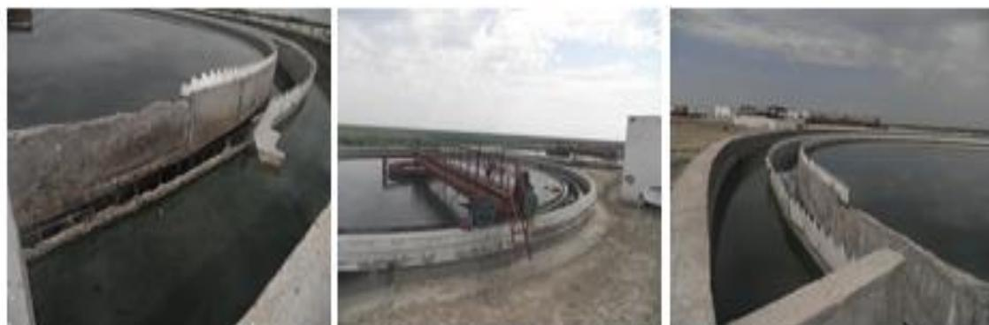
**Рисунок 2 – Вторичный радиальный отстойник**
