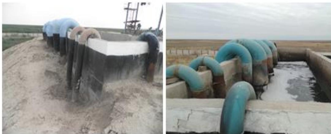
**Рисунок 1 – Приемная камера**
