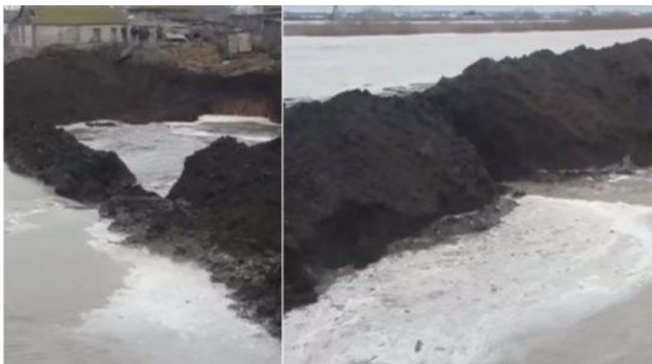
Рисунок 6.51. Разрушение насыпной дамбы у города Атбасар в 2017 году: https://tengrinews.kz/kazakhstan_news/pavodki-v-kazahstane-live-316268/
